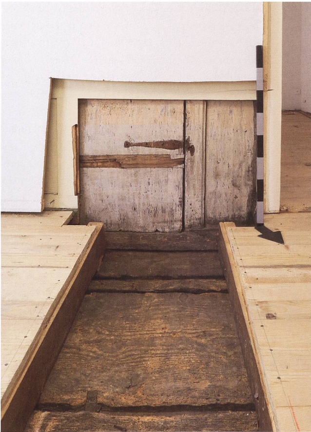
Abb. 5 Unteraltstadt 22, erstes Obergeschoss. Binnenwand auf Bohlenbalkendecke mit erhaltener Türsituation. Blick Richtung Süd.
