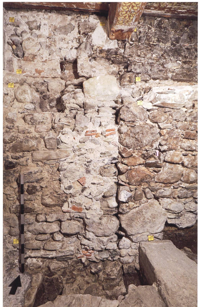
Abb. 7 Nordmauer von Unteraltstadt 24 im Erdgeschoss, Blick Richtung Nord. Wundvermauerung und Fundament der Sockelmauer sowie Negative eines Unterzugs, der nördlichen und östlichen Schelle und des nordöstlichen Eckständers des Gebäudes an der einstigen «Untergasse» (vgl. Anhang 3, rot).
