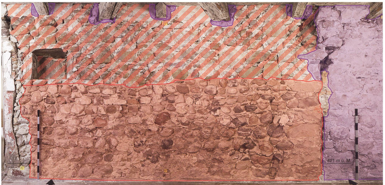
Abb. 3 Die Nordmauer von Unteraltstadt 22 im ersten Obergeschoss, Blick Richtung Nord. Rot bzw. rot schraffiert: Mauerreste von Gebäuden an der einstigen «Untergass». Im unteren Bereich (rot) gehörte die Mauer zu einem Gebäude auf der heutigen Parzelle Unteraltstadt 20, die Aufstockung (rot schraffiert) erfolgte jedoch für ein Gebäude auf Parzelle Unteraltstadt 22. Diese Mauerabschnitte zeigen deutliche Zeichen von einem Brand. Violett: Mauer, die den Ehgraben überbaut. Sämtliche auf der Fotomontage sichtbaren Deckenbalken datieren ins Jahr 1512 und geben damit einen Hinweis auf den spätesten Zeitpunkt der Überbauung des Ehgrabens.
