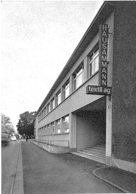
Haupteingang der Firma auf der St. Gallerstrasse
