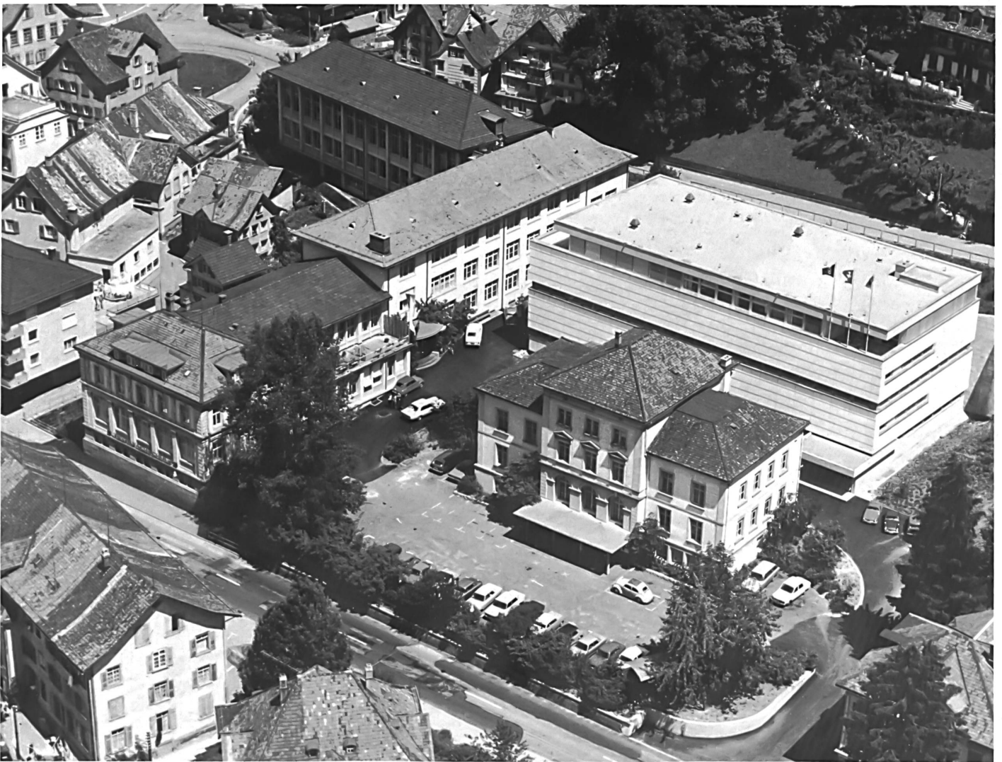
Gesamtansicht der Schweizerischen Textilfachschule Wattwil.
