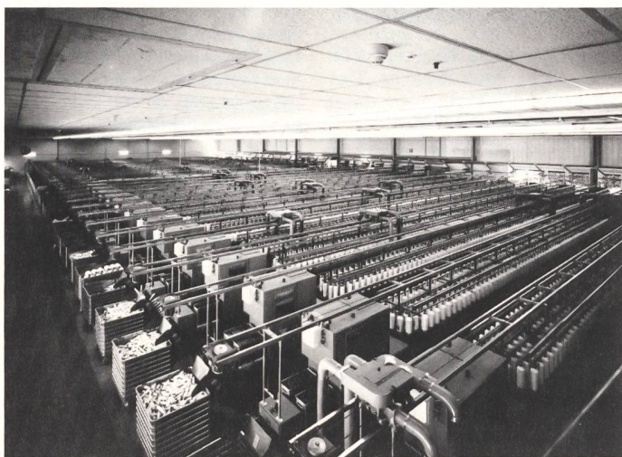
Ringspinnsaal im Neubau mit 34 der total 50 überlangen Ringspinnmaschinen, sämtliche mit Doffer ausgerüstet.
