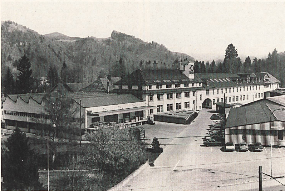
Die Geiser AG, Tentawerke in Hasle-Rüegsau.
