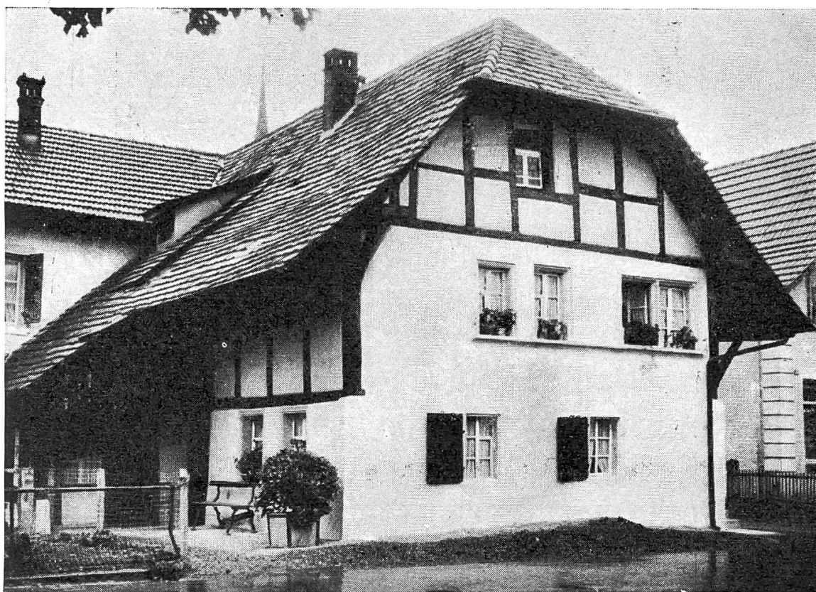
Haus Leuppi, Bahnhofstraße, Villmergen
