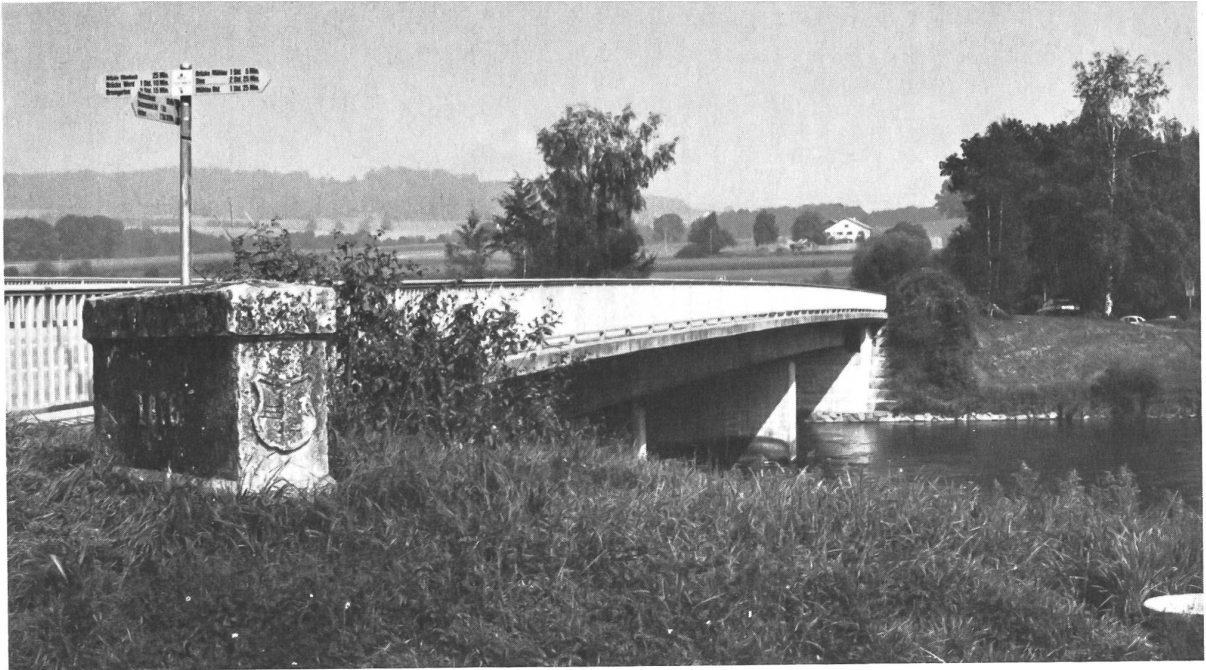
REUSSBRÜCKE VON 1971 Links vorne Teil des Brückenkopfes der Gitterbrücke von 1876 (Foto Hugo Müller. Muri)
