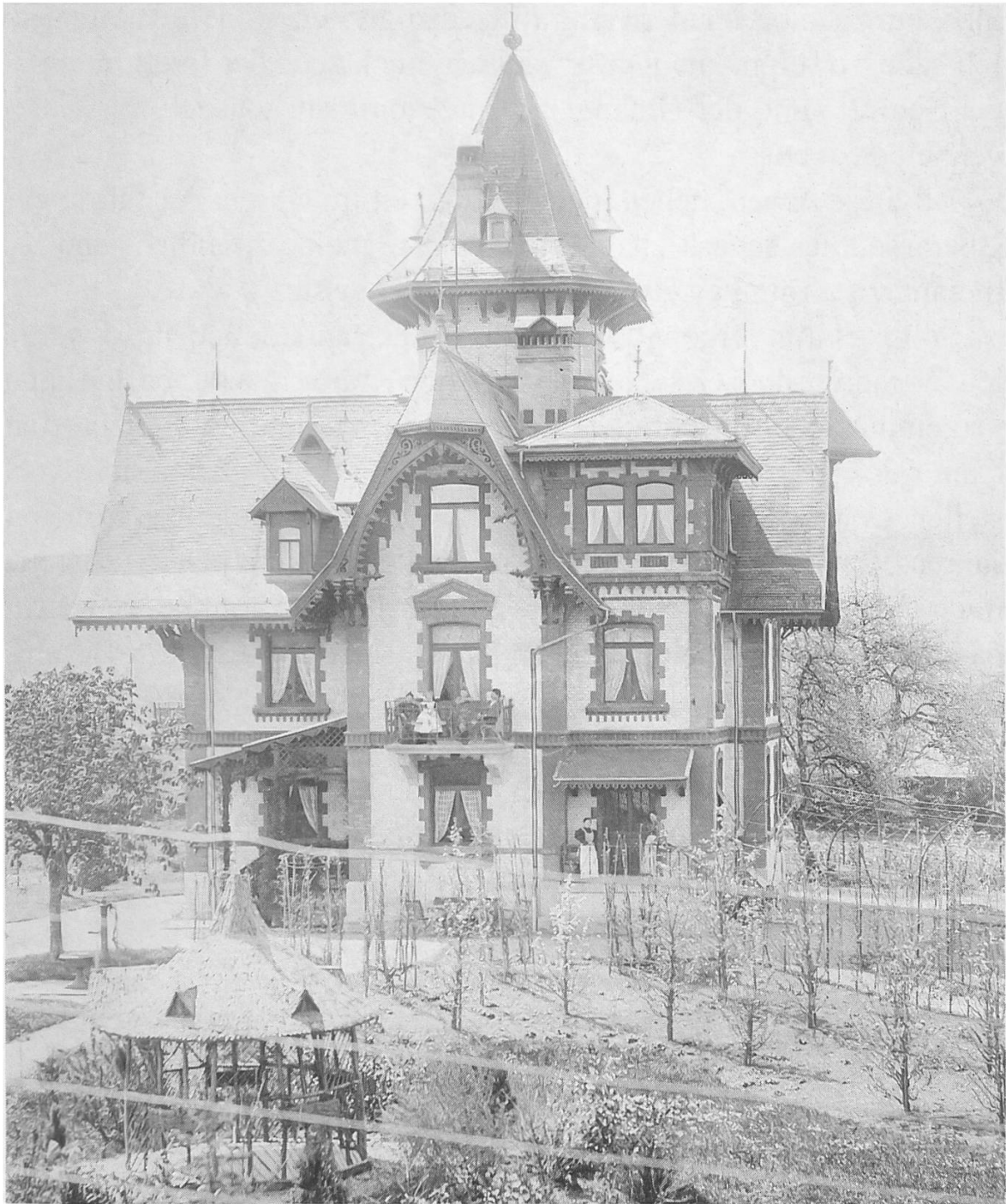
Wohnhaus Carl Vock, Wohlen, 1947 abgebrochen. 1894 erbaut am Bahnhofweg, dem Verwaltungsgebäude der Firma Georges Meyer & Co. gegenüber, Aufnahme von 1898. Der Bauherr Alois Isler, Bruder von Emanuel Isler, wohnhaft am Sternenplatz, musste Grundstück und Bauruine 1895 wegen Geldmangels an Carl Vock verkaufen. Villa im französischen Stil mit Gurtgesimse, Lisenen, Erkerturm mit Zeldach, Laube, Giebel mit Ornamenten und Dachluken.
