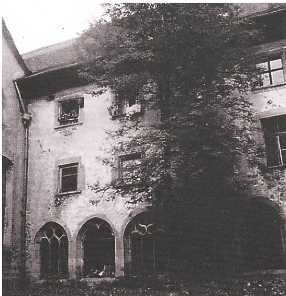
Kloster Muri, Kreuzgang. Zustand vor der Restau- rierung 1953 bis 1957.
