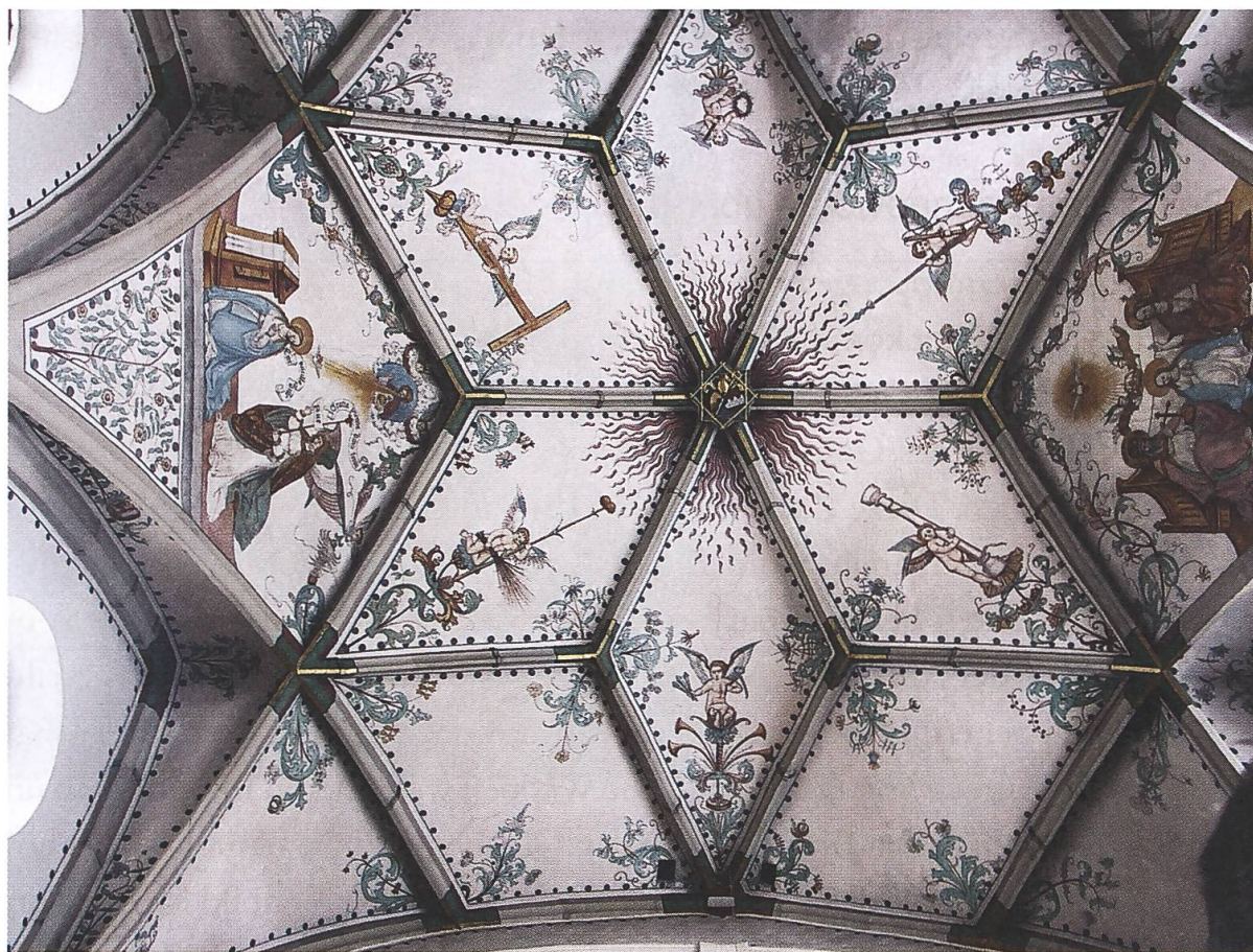
Abb. 20: Sternrippengewölbe des Hochchores in der Klosterkirche Muri. Foto: Bernhard Kägi.
