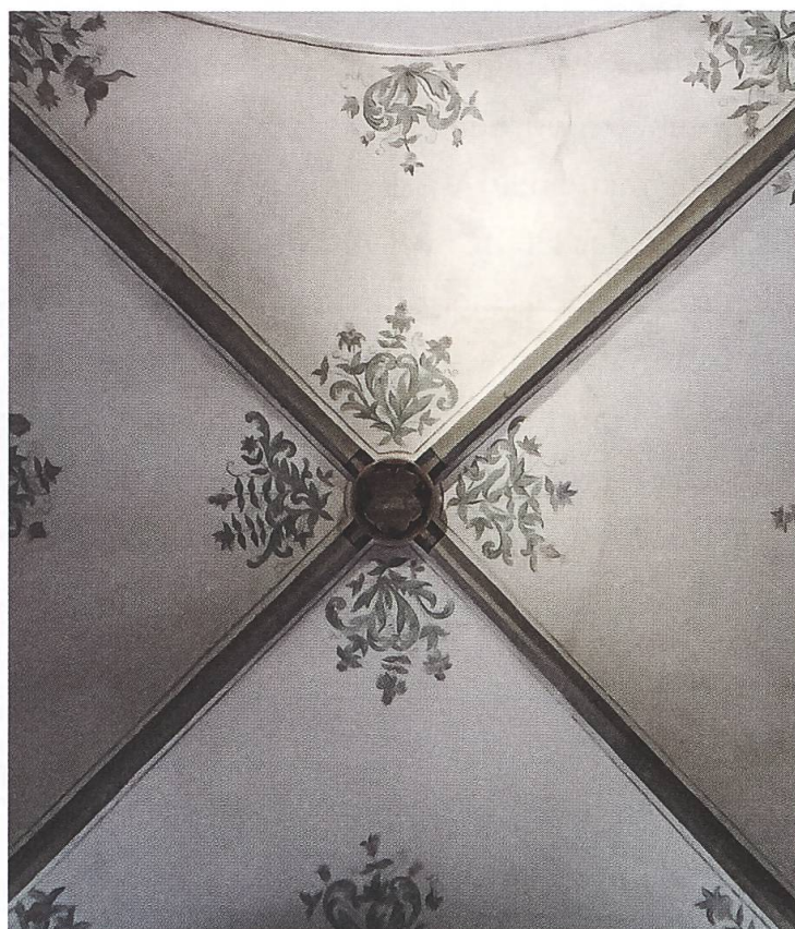
Abb. 18: Kreuzrippengewölbe im Kreuzgang Muri (Nordecke). Foto: Martin Allemann.
