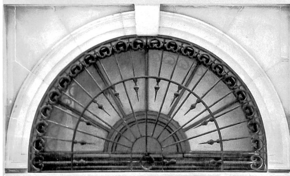
L'une des baies éclairant l'entresol du côté de la ruelle Notre-Dame
