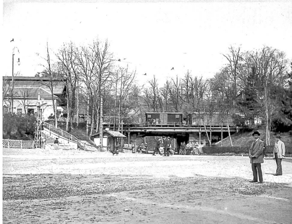
Le passage sous-voie de Beauregard en 1920 (P. Macherel, ASBC)
