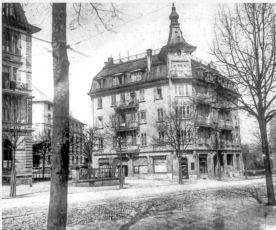
L'immeuble terminé, avec à l'arrière la minoterie de Pérolles, photo réalisée pour le dossier des architectes (ASBC)
