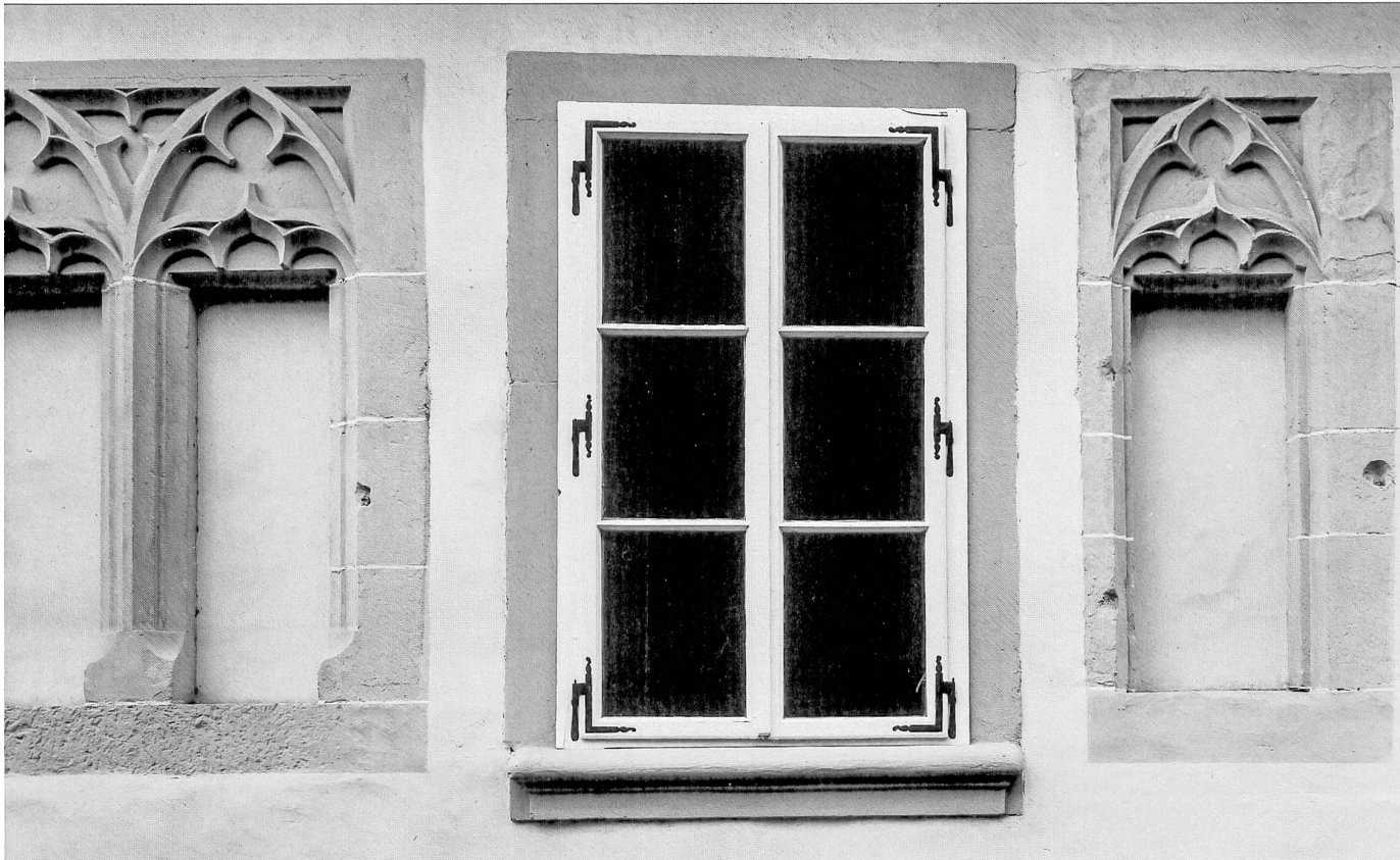
fenêtres du deuxième étage de la façade côté Stalden de la maison n° 2, datés de 1366 grâce à l'analyse dendrochronologique des bois insérés dans les maçonneries d'origine
