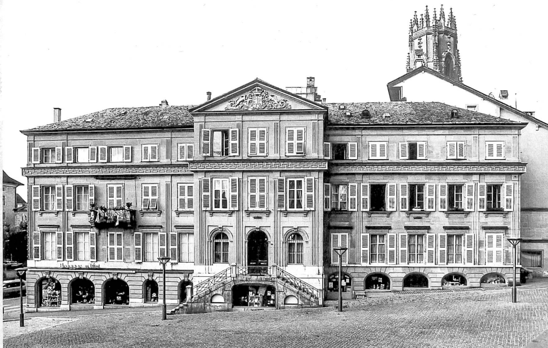
Immeuble construit en 1836-1839 sur les plans d'Henri Perregaux (1785-1850) pour Alfred d'Alt
