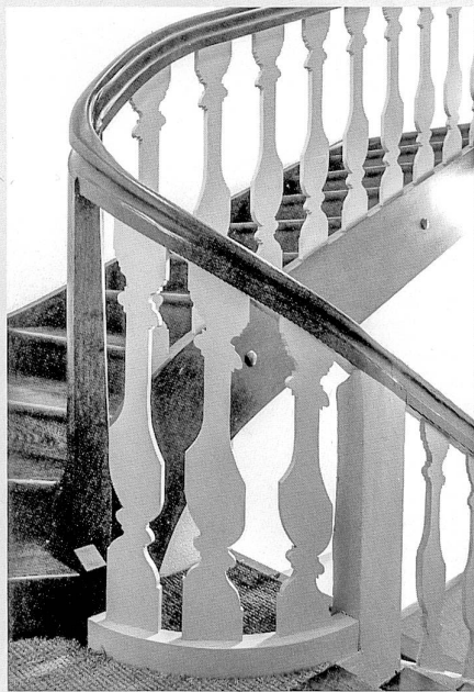
La rampe d'escalier, à balustres chantournées, 1830-1831
