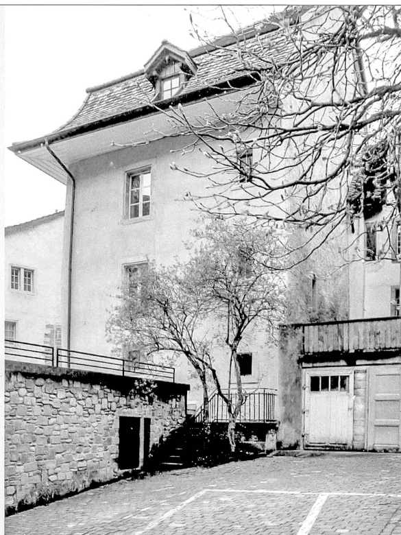
La façade nord et le mur pignon ouest. L'annexe des latrines et l'écurie ont été démolis dans les années 1920
