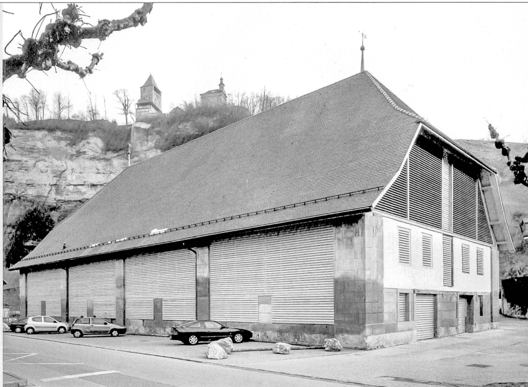
Le Grand Werkhof reconstruit plus beau qu'avant sur les ruines de ce qui fut l'un des plus grands chantiers médiévaux de Suisse
