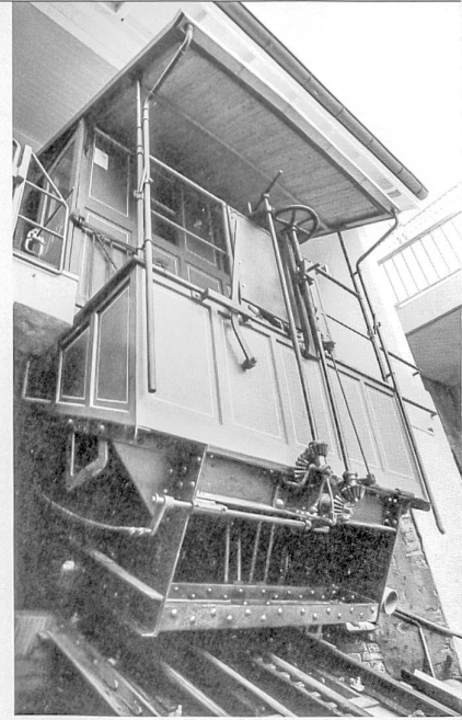
La voiture amont en cours de remplissage
