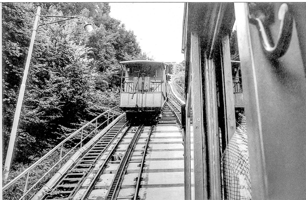
Croisement terminé: la voiture lestée d'eaux usées file à 4 km/h vers la station inférieure entraînant par contreponds le véhicule opposé
