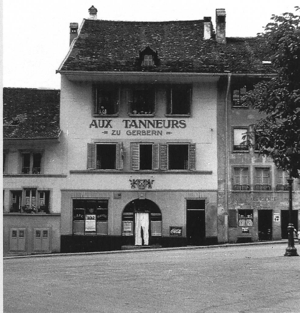
Etat avant la transformation de 1950 (ASBC, Photothèque)
