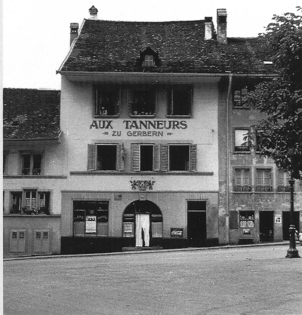
Etat avant la transformation de 1950 (ASBC, Photothèque)
