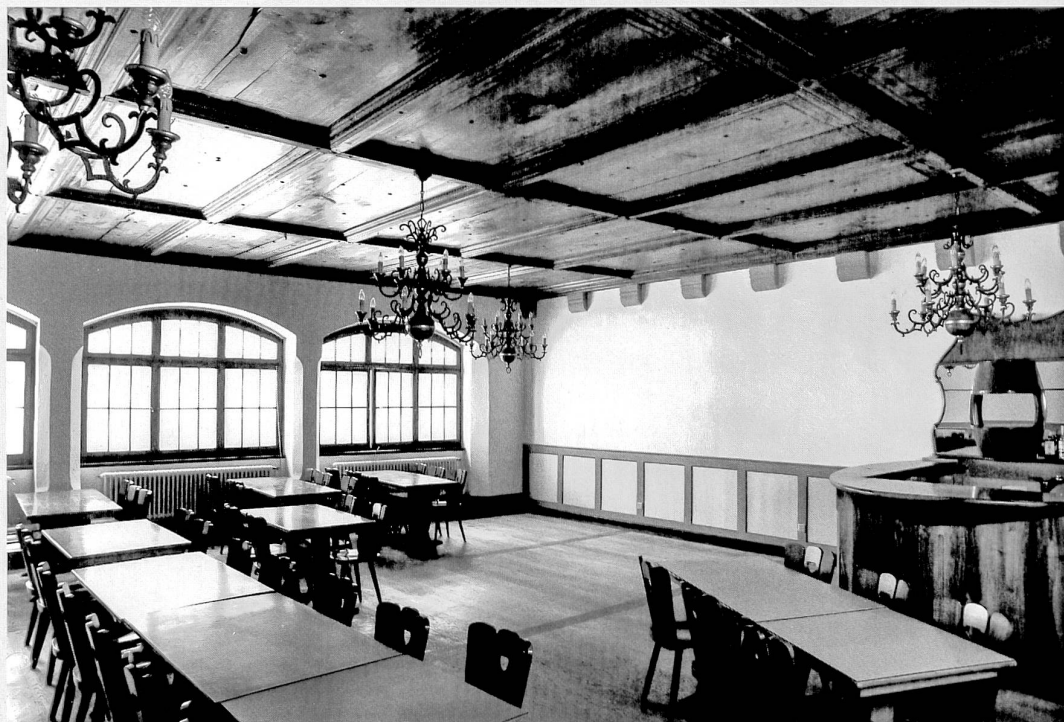
La grande salle du 1 er étage, avec son plafond à caissons des années 1560-1570
