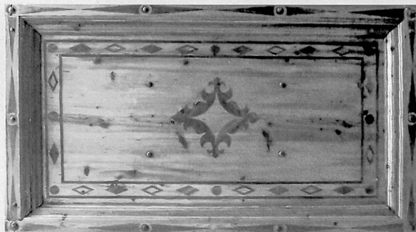
Détail d'un des panneaux marquetés du plafond, épicéa incrusté de noyer
