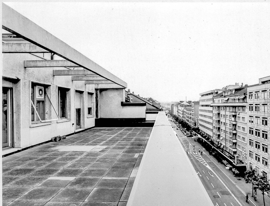
La terrasse de l'attique
