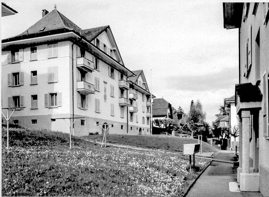
Côté sud, les maisons de la Fraternelle et leur jardin collectif. Profitant de la déclivité du terrain, l'arc central permet un accès direct aux caves.
