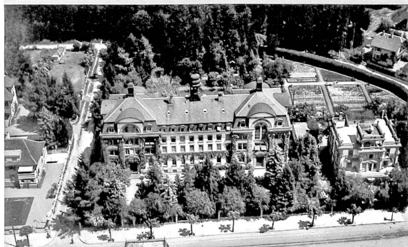
Vue aérienne du site du Gymnase cantonal des jeunes filles, avec l'Académie et la Villa Felix, construite pour le comptable Paul Pasquier, 1933 (Archiv Institut Menzingen, carte postale, Verlag O. Wyrsh, Krienz)
