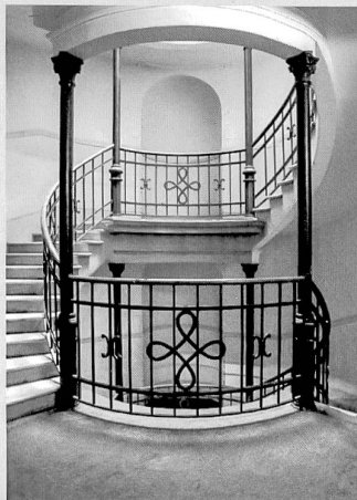
La cage d'escalier: marches en marbre de Carrare, colonnes et rampe en fer forgé. Cet espace est l'un des rares à avoir conservé son aspect initial.
