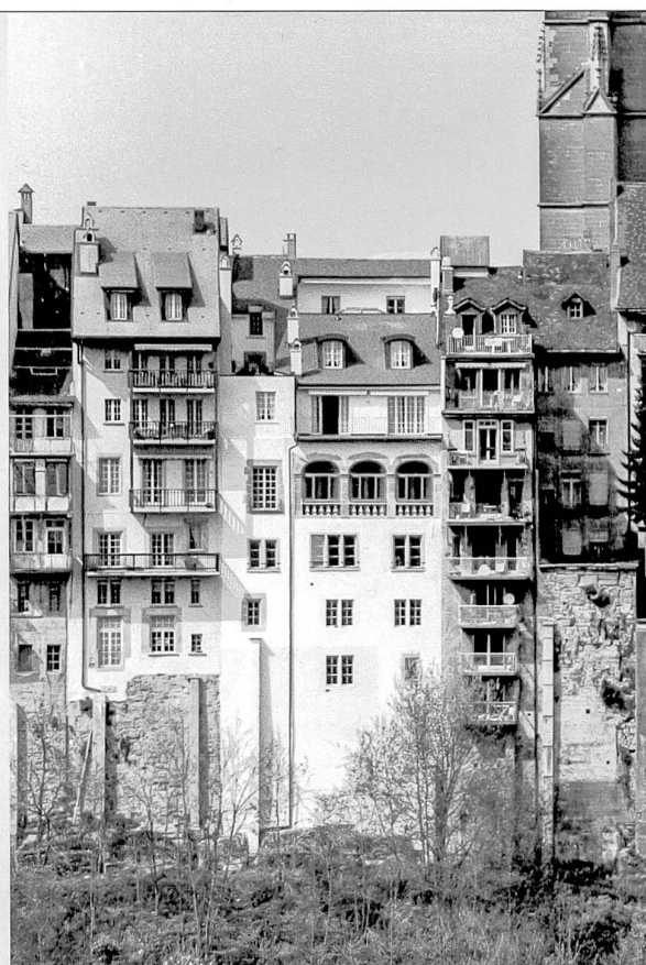
Dressée au-dessus des jardins des Rames, la façade sud après restauration, avec sa galerie de 1759-1761 et la surélévation de 1898
