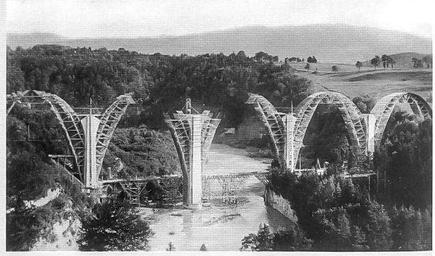
Les cintres en construction, œuvre maîtresse de Richard Coray, le 12 septembre 1921, un an après la bénédiction de la 1 re pierre (Paul Savigny, ASBC, carte postale)
