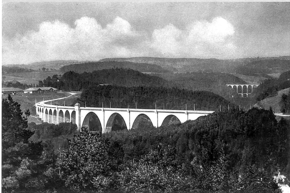
En 1923, les arches du pont de Pérolles et celles du pont de la Glâne (1853-1856), en écho (ASBC, carte postale)
