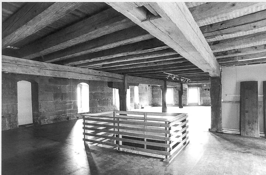
Le premier étage du grenier de 1527, avec sa trappe de chargement au premier plan
