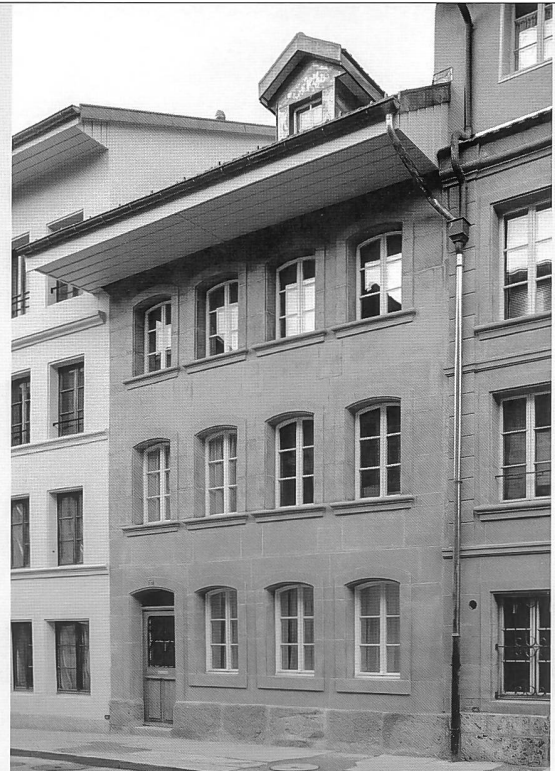
La façade sur rue de la maison n° 17, construite en 1769-1770, probablement pour Jean-Guillaume de Daguet
