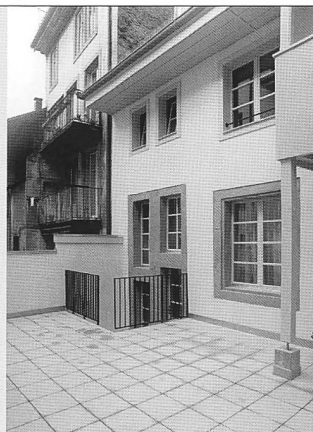
La façade arrière du Gothard, après restauration
