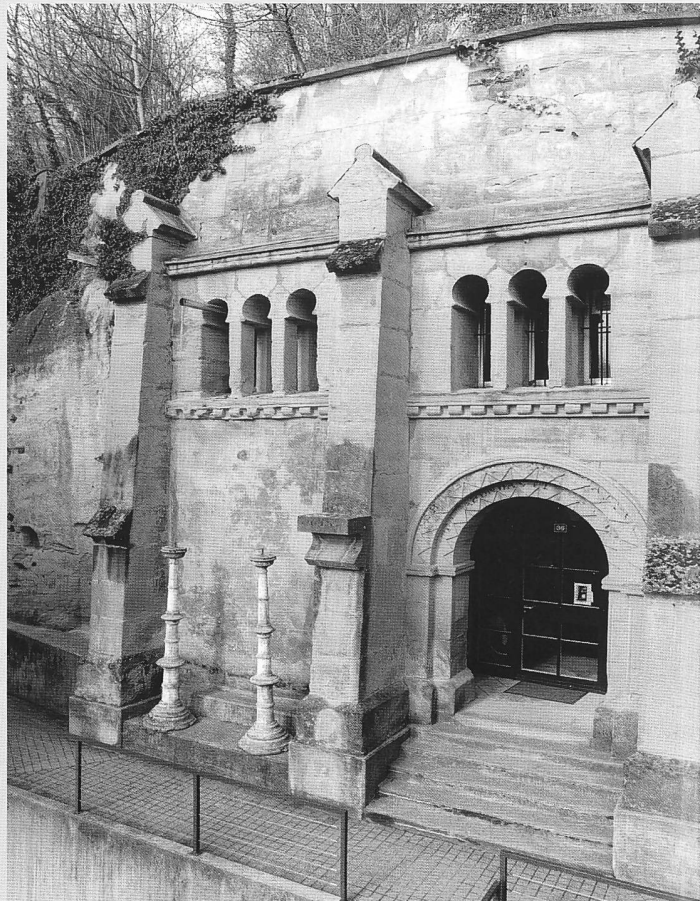
Façade d'entrée de l'actuelle Espace-Pertuis, aménagée en 1985 dans l'ancienne grotte des francs-maçons: une élévation byzantino-mauresque de 8 m pour un sanctuaire rupestre long de 20 m
