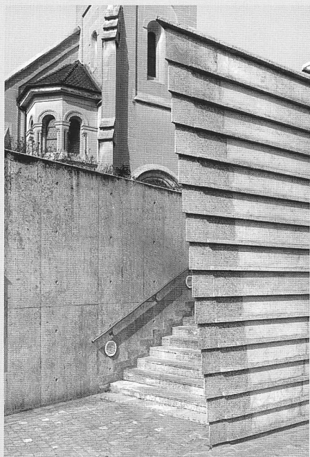
Détail de l'escalier du parvis et du mur de protection de Thomas Urfer, inaugurés le 25 juin 1995
