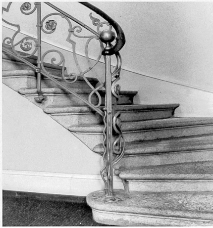
Départ de la rampe d'escalier réalisée par les frères Hertling d'après le dessin de leur cousin, Léon Hertling, 1904
