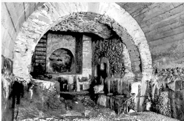
Ancien puits de turbines, état actuel
