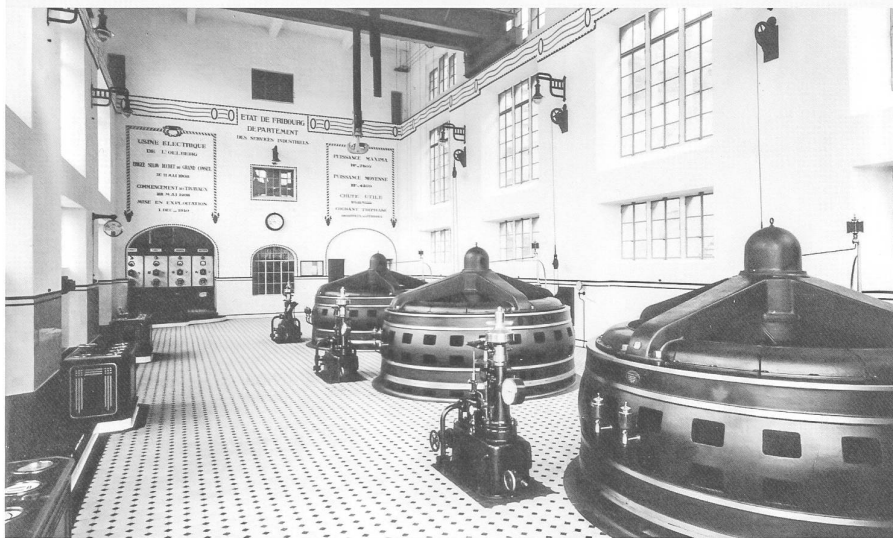
Propre comme une église de campagne: la salle des machines en 1910, avec son décor aquatique de Broillet & Wulfleff et les trois génératrices Alioth cernées d'un carrelage blanc piqué de noir
