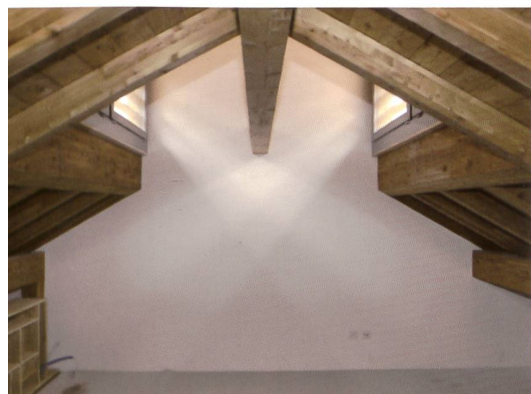
VUE DE LA CHAMBRE À COUCHER AMÉNAGÉE SOUS LE LANTERNEAU COUVRANT LES ANCIENS BACS RAFFRAÏCHISSEURS
