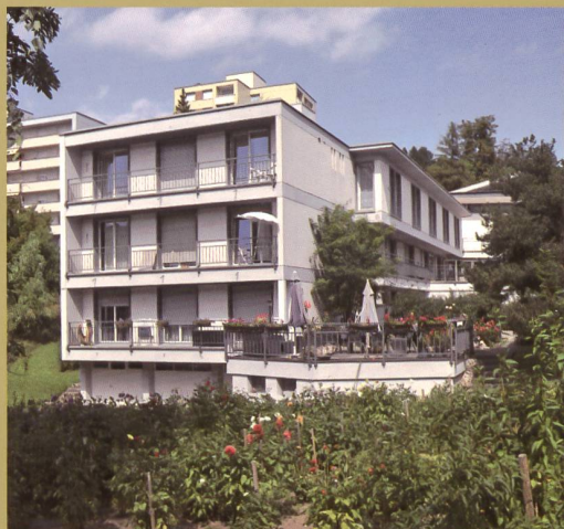
LES LOGGIAS DE LA CURE, PLEIN SUD
