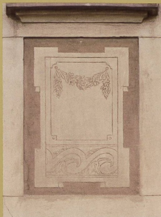
DÉTAILS DU DÉCOR DE SGRAFFITE EN FAÇADE ORIENTALE: UN CARTOUCHE EN GUISE DE CHAPITEAU SUR LES ANGLES, DES TABLES LIANT LES BAIES, DES ENTRELACS ET DES TORES DE LAURIER. ATELIER DEMARTA FRÈRES (?), 1912
