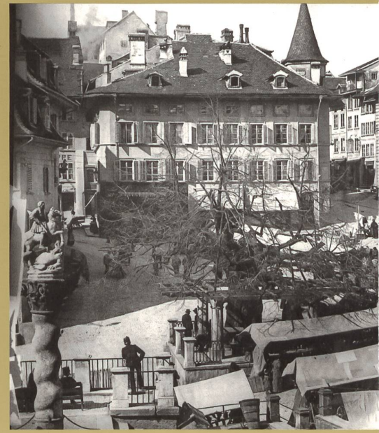
MARCHÉ D'HIVER EN 1893. LE TILLEUL DÉNUDÉ RÉVÈLE LA STRUCTURE D'UN BASSIN ENCREMENTÉ EN CARRÉ QUI ENCOMBRE LA PLACE (BCUF, FONDS LÉON DE WECK ET GEORGES)
