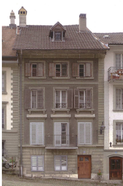
LA MAISON DE L'ENTREPRENEUR JOSEPH KAESER, PLANCHE-SUPÉRIEURE 22, RECONSTRUITE PAR SES SOINS ET ACHÉVÉE EN 1838
