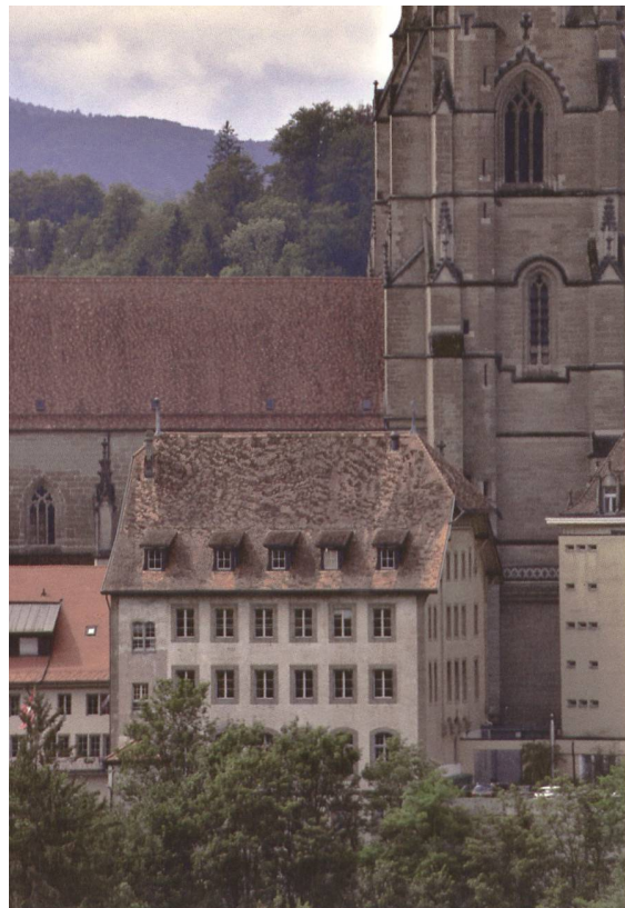
LA FAÇADE ARRIÈRE DE L'ÉCOLE DES GARÇONS AVEC LES SIX BAIES À LINTEAU DROIT ÉCLAIRANT CHAQUE SALLE DE CLASSE, LE PREMIER AXE DU CÔTÉ DE LA CURE CORRESPONDANT À L'ANCIENNE ANNEXE DES LATRINES HORS ŒUVRE DESSERVANT TOUS LES NIVEAUX
