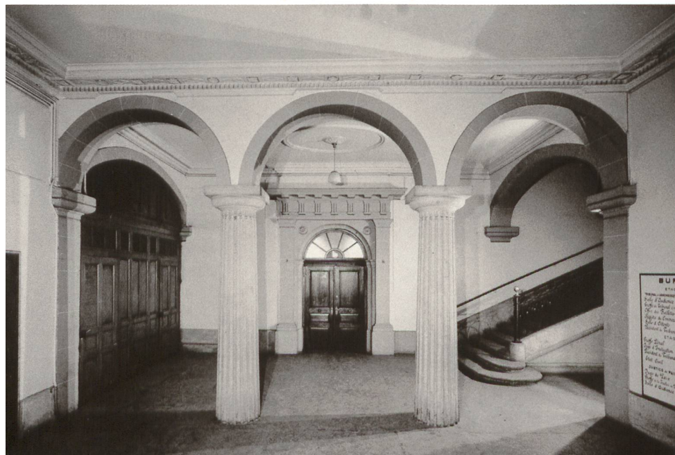
LE VESTIBULE DU REZ-DE-DE-CHAUSSÉE ET L'ENTRÉE DE LA SALLE DU CONSEIL GÉNÉRAL, VERS 1964, AVEC LA PAROI FERMANT L'ACCÈS AUX SOUS-SOLS (SBC, JACQUES THÉVOZ)
