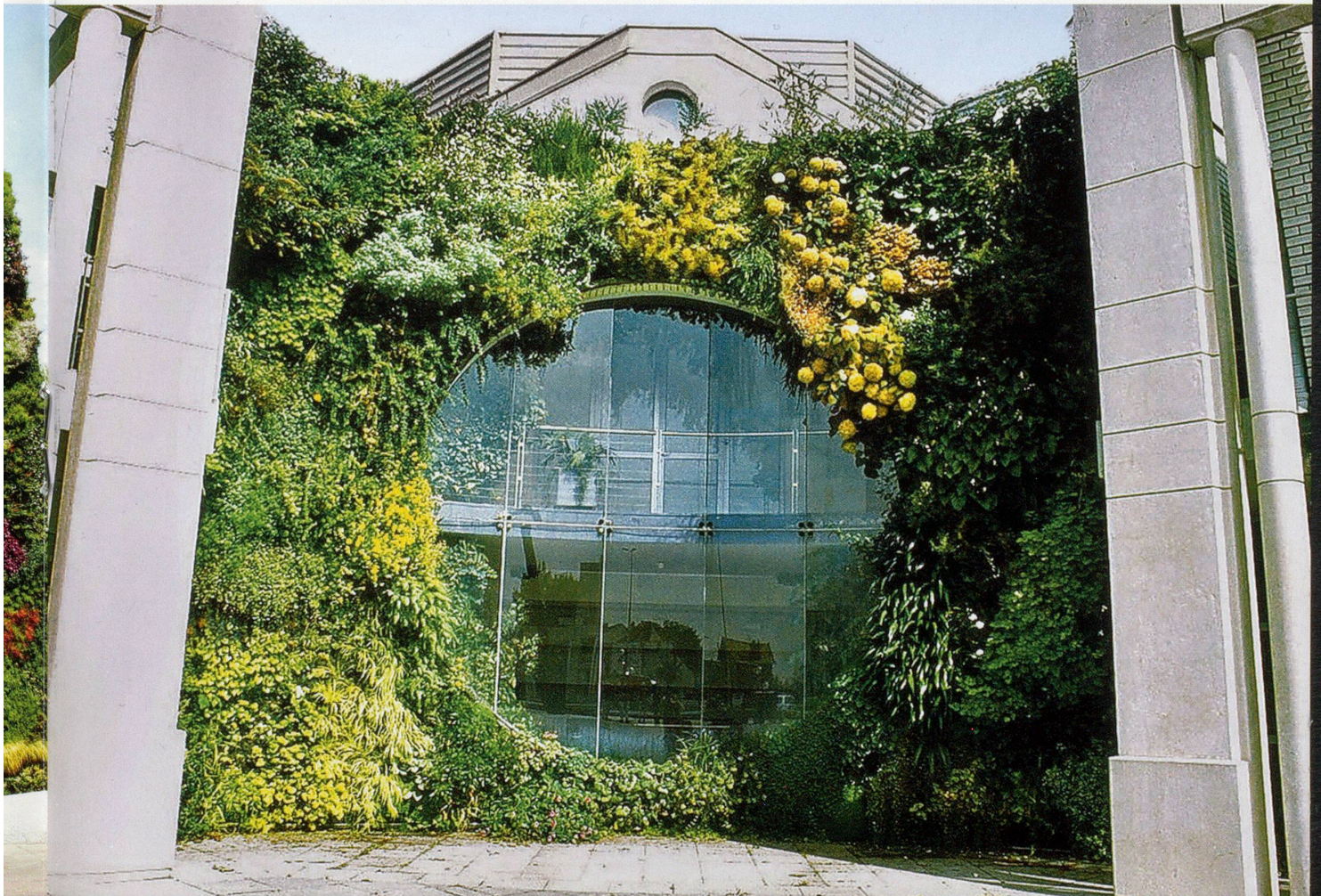
Die grüne Wand am Kulturforum in Le Blanc-Mesnil, einer 50000-Einwohner-Stadt im Nordosten von Paris, fertiggestellt 1999.
