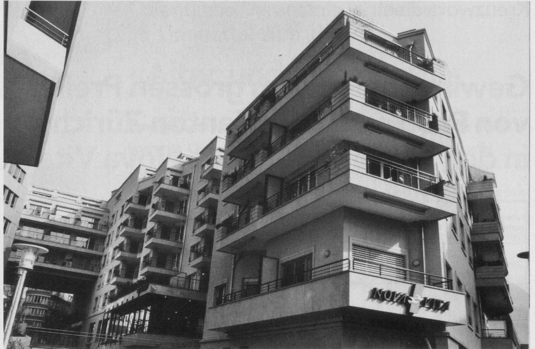
Die erst kürzlich fertiggestellte Seniorenresidenz von aussen.
