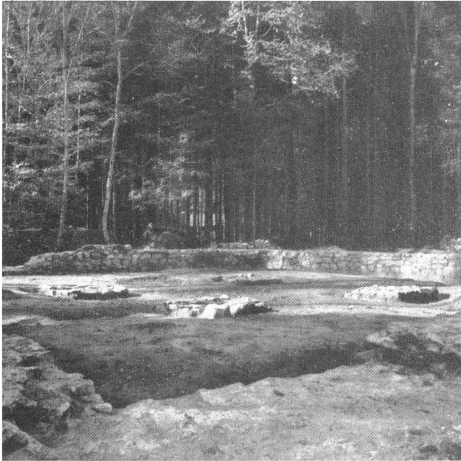
Abb. 5 Römerwarte «Stelli» bei Wallbach. Inneres mit 4 Pfeilerfundamenten, vor der Konservierung.
