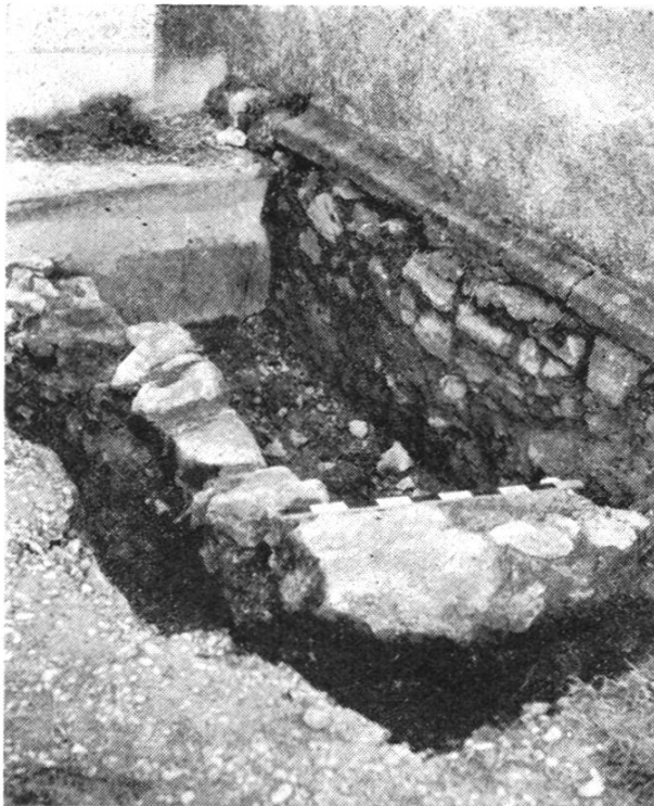
Abb. 4. Altes Mauerwerk nördlich des Turmes.
