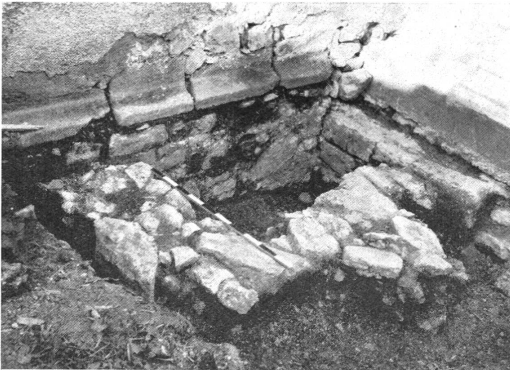
Abb. 3. Altes Mauerwerk südlich des Turmes.
