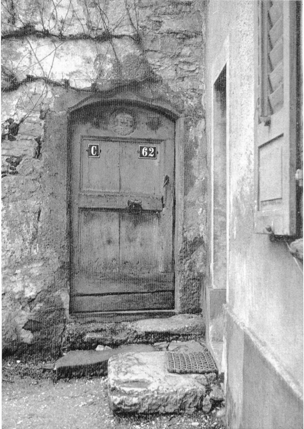
Eingang zum Treppenturm
