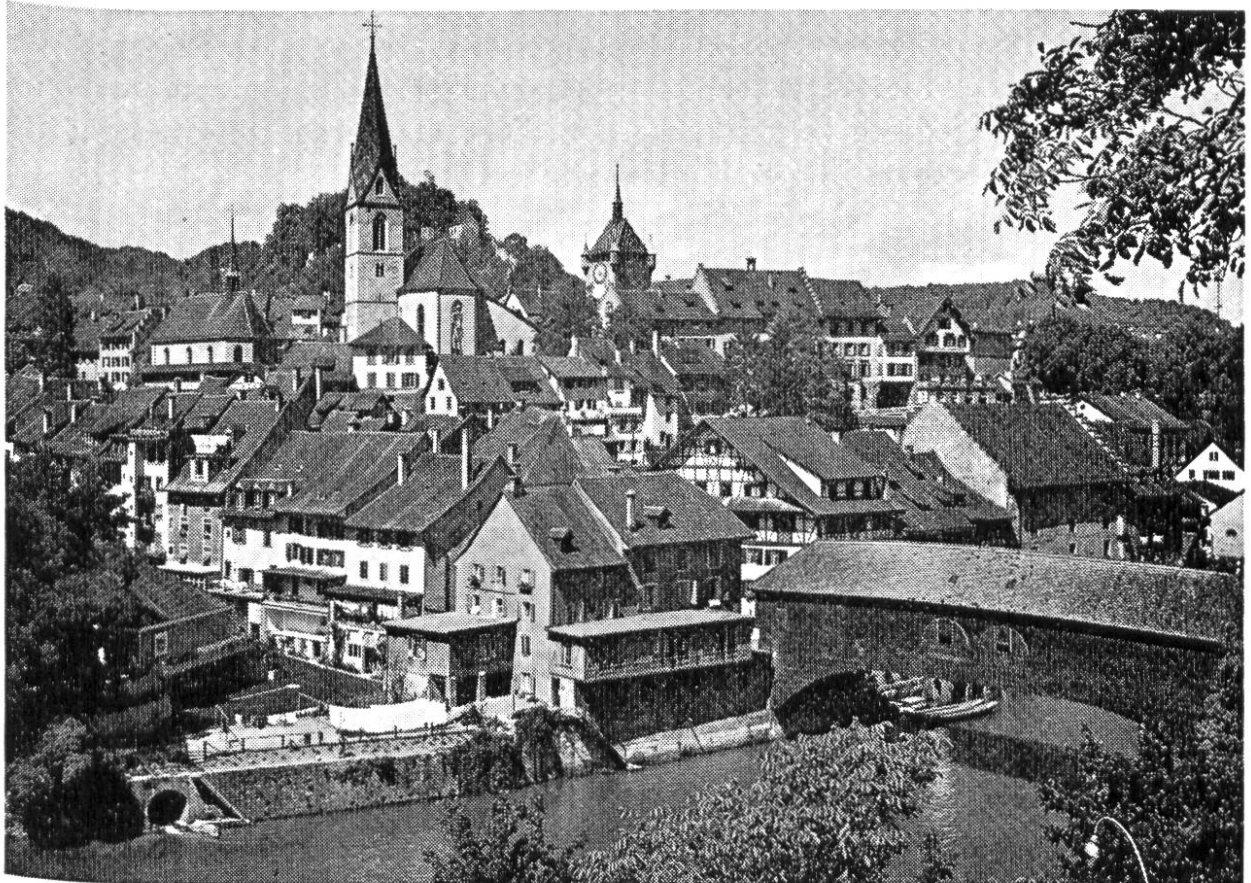
Limmatbrücke Baden 1809. Ansicht mit Altstadt.
