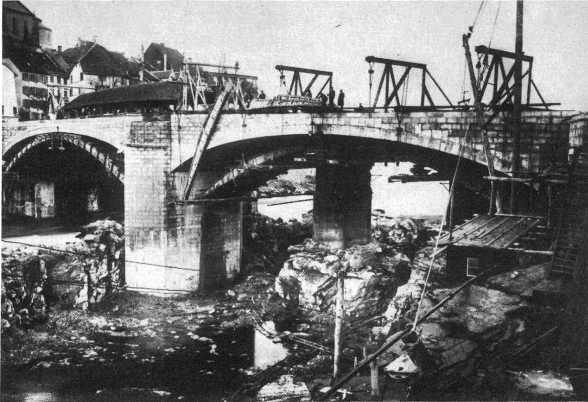
Neue Rheinbrücke. Ausbau des Lehrgerüsts (28. Dezember 1911)
