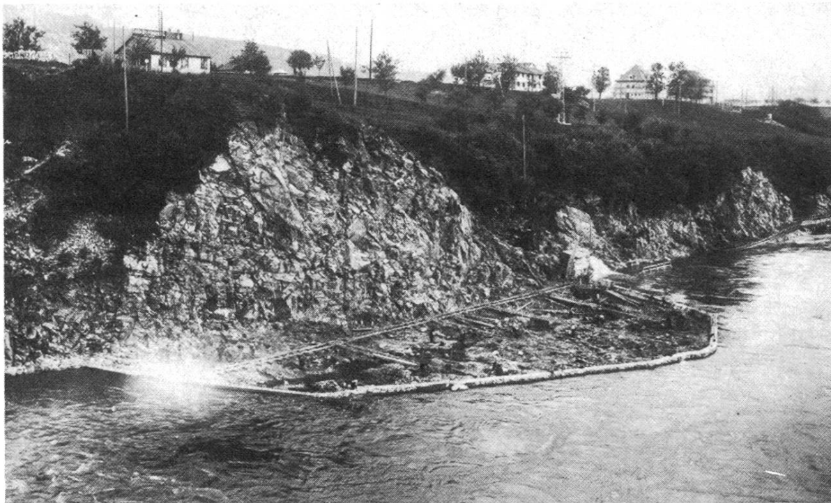
Sprengarbeiten in der «Enge» (5. Mai 1912)
