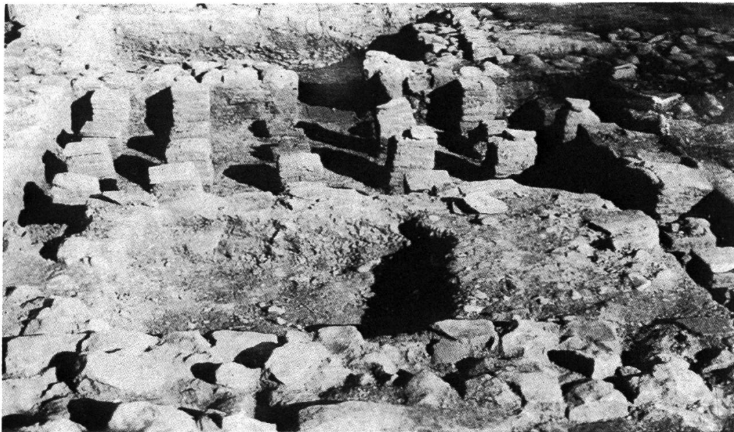
Abb. 10: Ein Teil des römischen Bades von Warmbach. Dieser Raum mit den Hypokaustpfeilern diente als Heisswasserbad, das vom dahinter gelegenen Raum aus beheizt wurde. Ganz im Vordergrund das massive Fundament einer Wasserwanne.
