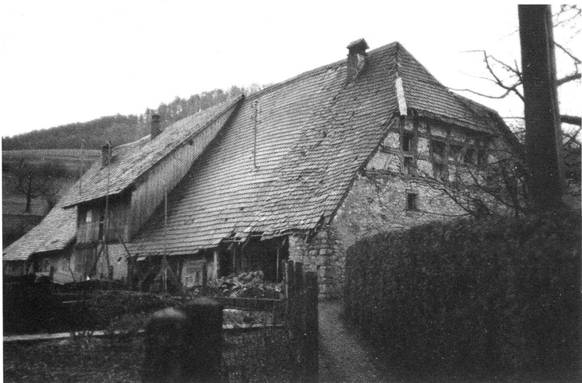
Abb. 2: Ansicht des Hauses von Nordwesten vor dem Abbruch. Rechts Westhaus mit Riegelwerk, datiert etwa 1712. (Foto: Alfons Henzmann)
