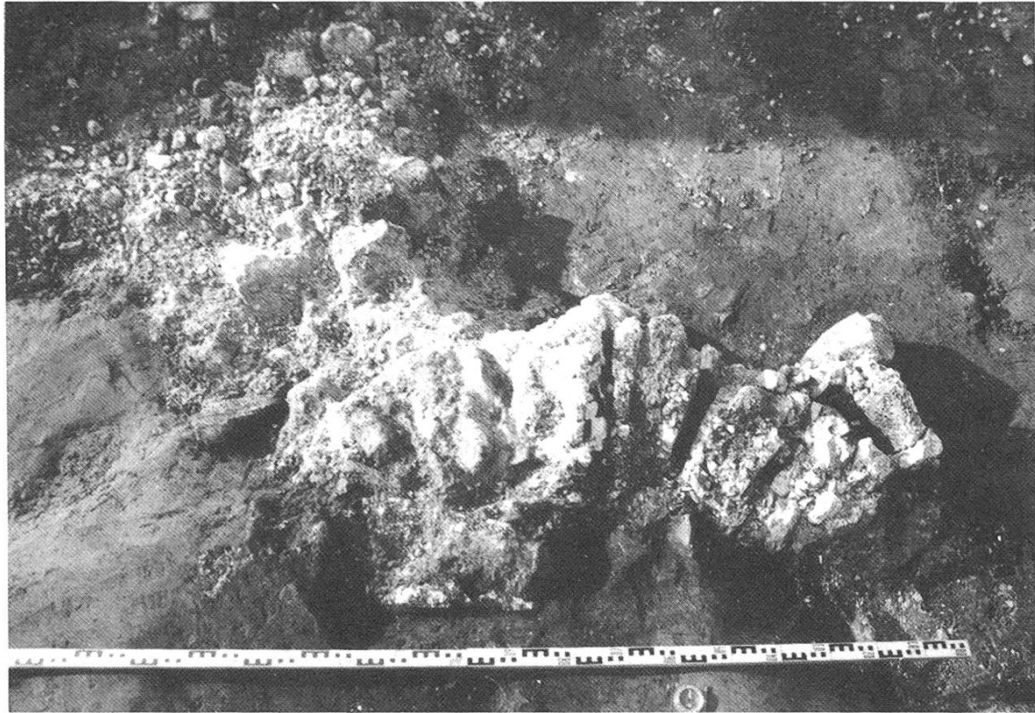
Abb. 4: Rheinsulz, Reste eines eingestürzten Fenstergerüsts.
