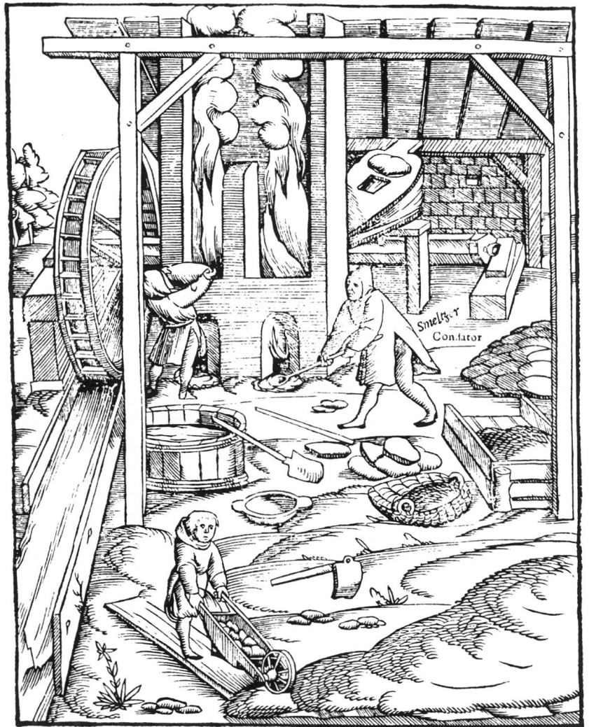
Abb. 3 Eine Bläje, wie sie Sebastian Münster in seiner Kosmographie von 1550 dargestellt hat. Hinter dem Blasofen ist deutlich der vom Wasserrad angetriebene Blasebalg zu erkennen.
